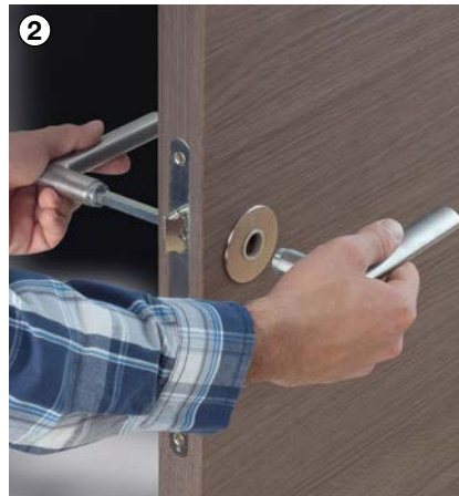
2 Sklapanje kljuk za vrata
