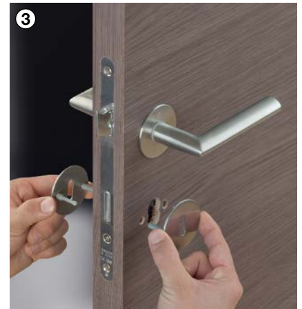
3 Po potrebi spojite spodnji rozeti – končano!
